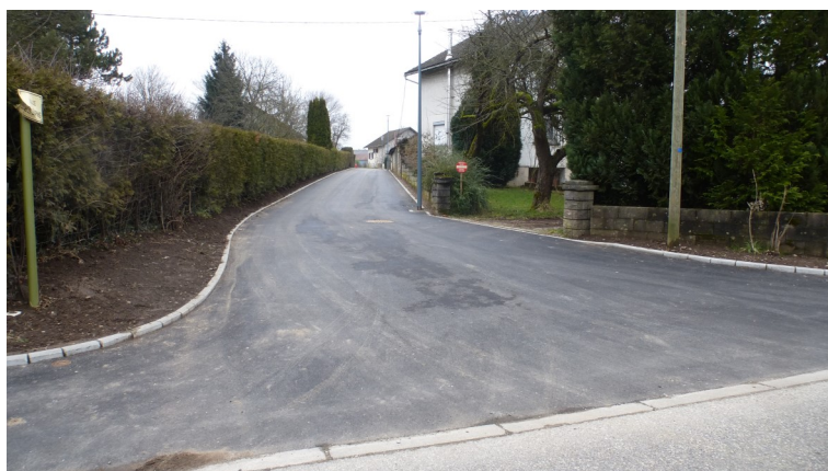
Nouvel éclairage public et nouvelle chaussée pour l'Allée des Sapins.
