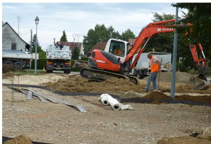
*Début des travaux avec le terrassement et la pose des voliges permettant d'identifier les jeux et les cheminements.*
